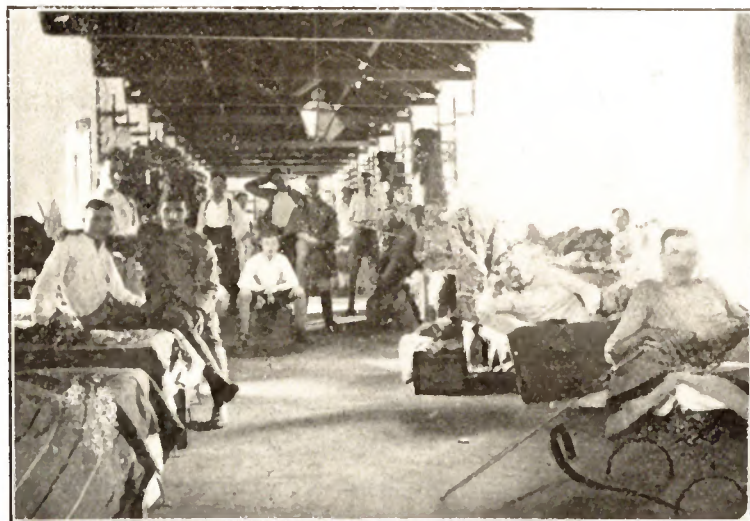
CASERNA I — (Depósito de material de pontes)
