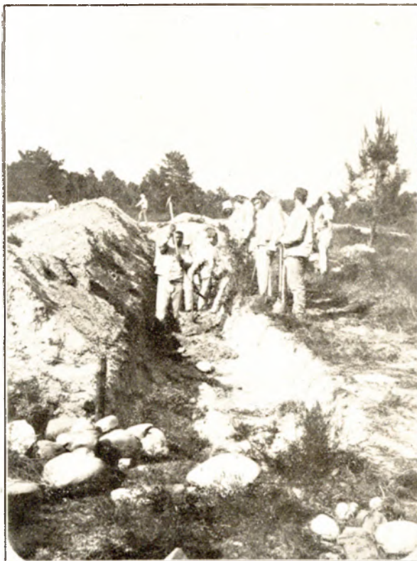
ESCOLA DE APLICAÇÃO DE ENGENHARIA — Trabalhos de sapa
