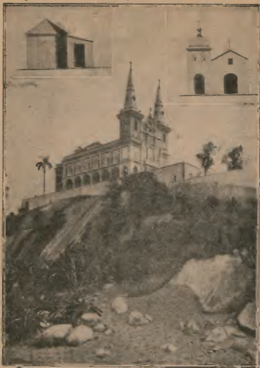
Igreja da Penha, no Rio de Janeiro. Mandada edificar e ampliar pelos portugueses, em 1635, 1728 e 1926
