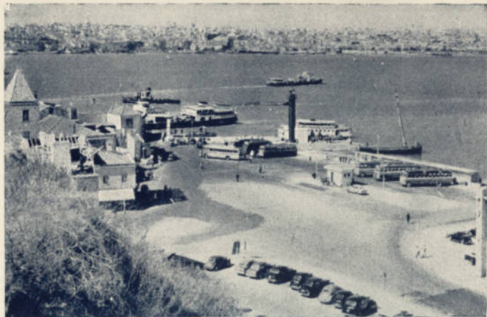
CACILHAS — Vista Geral do Cais CACILHAS — General view of the quay
